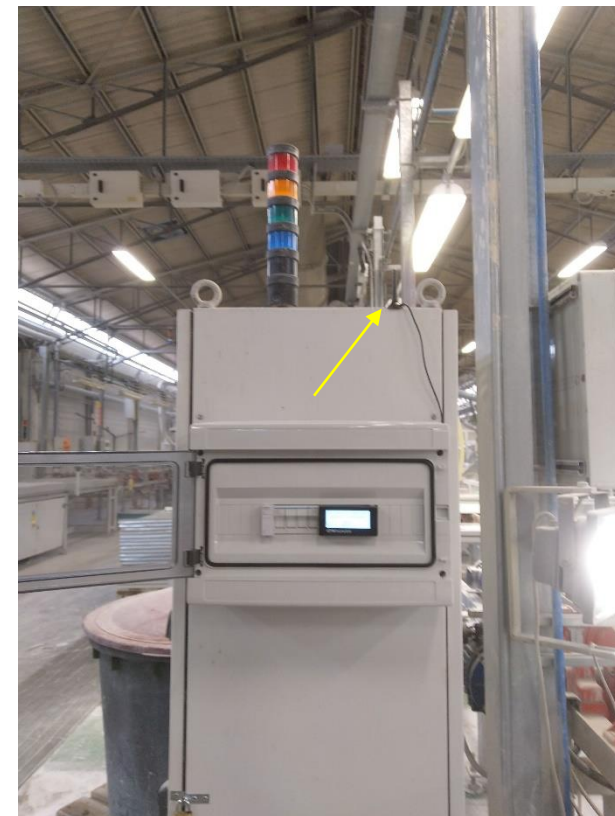
Collegamento radio con il MES
